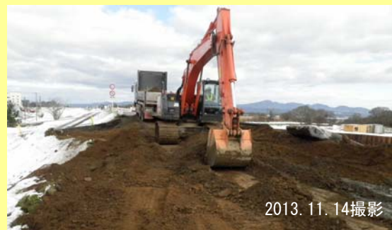
▲ 堤防掘削開始の様子
