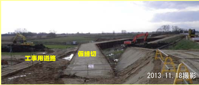
▲ 下流側から上流方向
